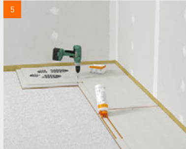
Verlegen der fermacell® Estrich-Elemente auf fermacell™ Ausgleichsschüttung
