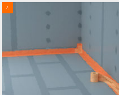
In die feuchte Flüssigfolie das fermacell™ Dichtband eindrücken
