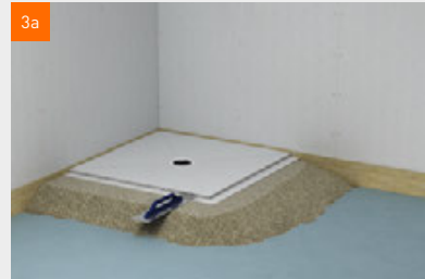
Variante A: Um das Duschelement wird in Höhe des überstehenden Falzes ein ca. 200 mm breiter Damm geschüttet – als Auflage für das Abziehen der restlichen Fläche
