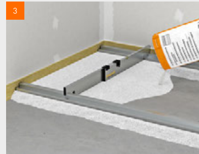
fermacell™ Ausgleichsschüttung einbringen
