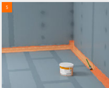
Dichtband direkt nach dem Eindrücken mit fermacell™ Flüssigfolie überstreichen - Trocknungszeit mindestens 1 Stunde
