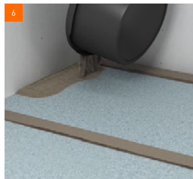
Anschließend wird die Gebundene Schüttung T zwischen den Dämmen ausgebracht ...
