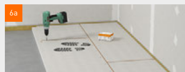
3 Verlegen der fermacell® Estrich-Elemente
