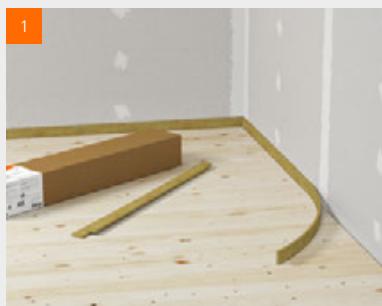
1 Randdämmstreifen verlegen und in den Ecken stumpf stoßen
