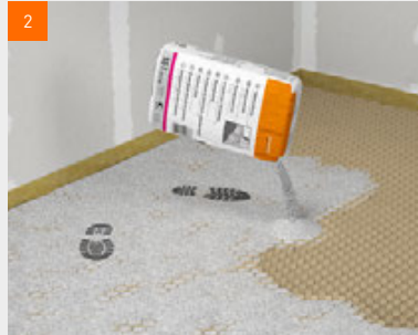
fermacell™ Wabenschüttung einbringen
