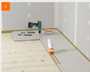
4 Auftragen des fermacell™ Estrich-Klebers im Falzbereich
