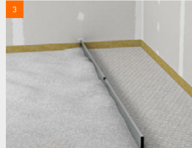
fermacell™ Wabenschüttung abziehen
