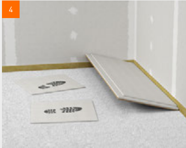
Verlegen der fermacell® Estrich-Elemente auf fermacell™ Ausgleichsschüttung
