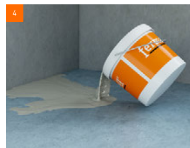
Boden-Nivelliermasse ausbringen und planeben nivellieren
