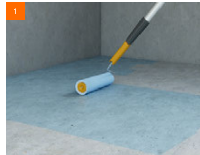
Vorbereitung: Boden grundieren
