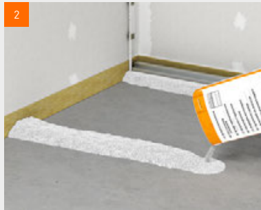
Anlegen der Dämme
