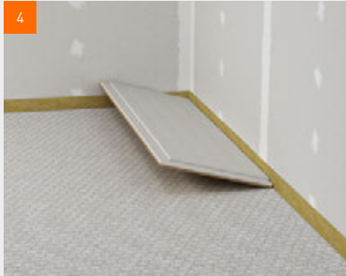
fermacell® Estrich-Elemente verlegen
