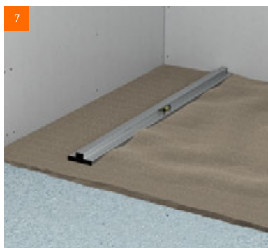
... und auf den leicht verdichteten Dämmen abgezogen
