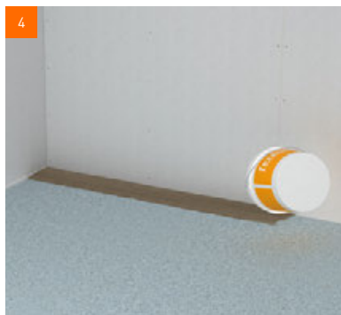
Anschließend hat die Gebundene Schüttung T eine erdfeuchte Konsistenz. Der erste Damm wird angelegt
