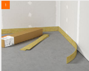
Anbringen der Randdämmstreifen
