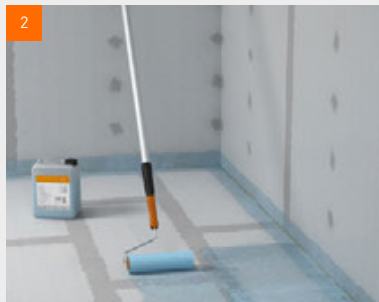
... und Bodenbereich per Rolle auftragen - Trocknungszeit mindestens 2 Stunden
