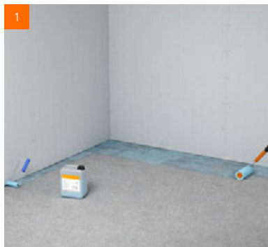
Grundierung des Untergrundes mit fermacell™ Tiefengrund
