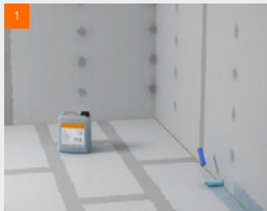
fermacell™ Tiefengrund im angrenzenden Wandbereich ...
