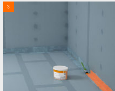
fermacell™ Flüssigfolie in der Ecke auftragen
