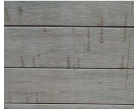
Fleckenbildung durch von Regen angelöste Partikel
