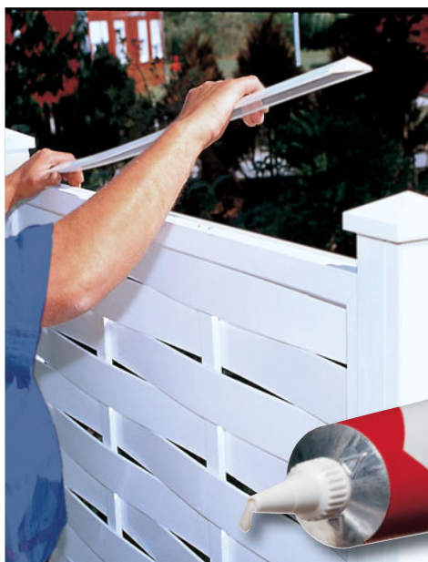
Kleber (0783) zur Befestigung der Aufsatzleisten und der Kunststoffkappen.
