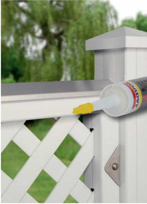
Designaufsatz Alu mit MS-Polymer-Kleber (1398) befestigen.
