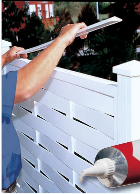
Kleber (0783) zur Befestigung der Aufsatzleisten und der Kunststoffkappen.
